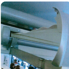
Παράδειγμα κατεστραμένου πανιού όπου εμφανίζεται το φαινόμενο «κυματισμού»
